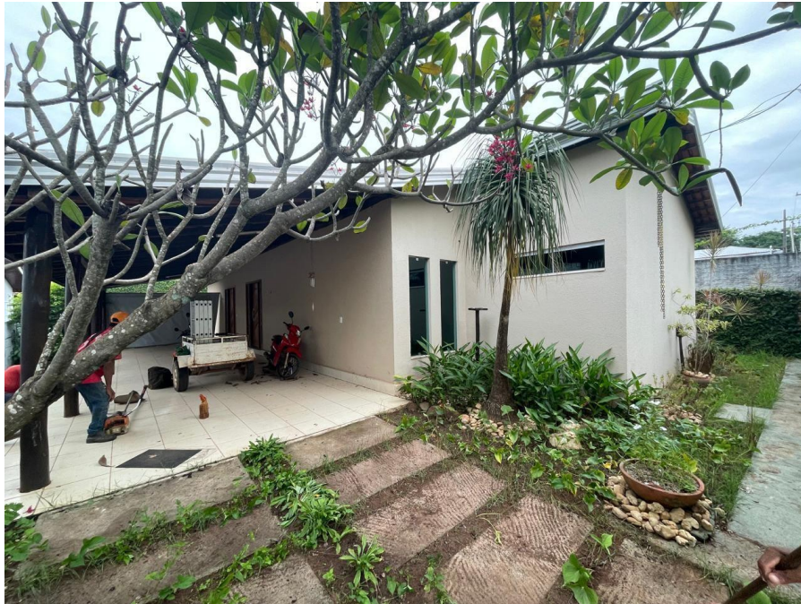
IMAGEM 4: VISTA ANTERIOR DA EDIFICAÇÃO
