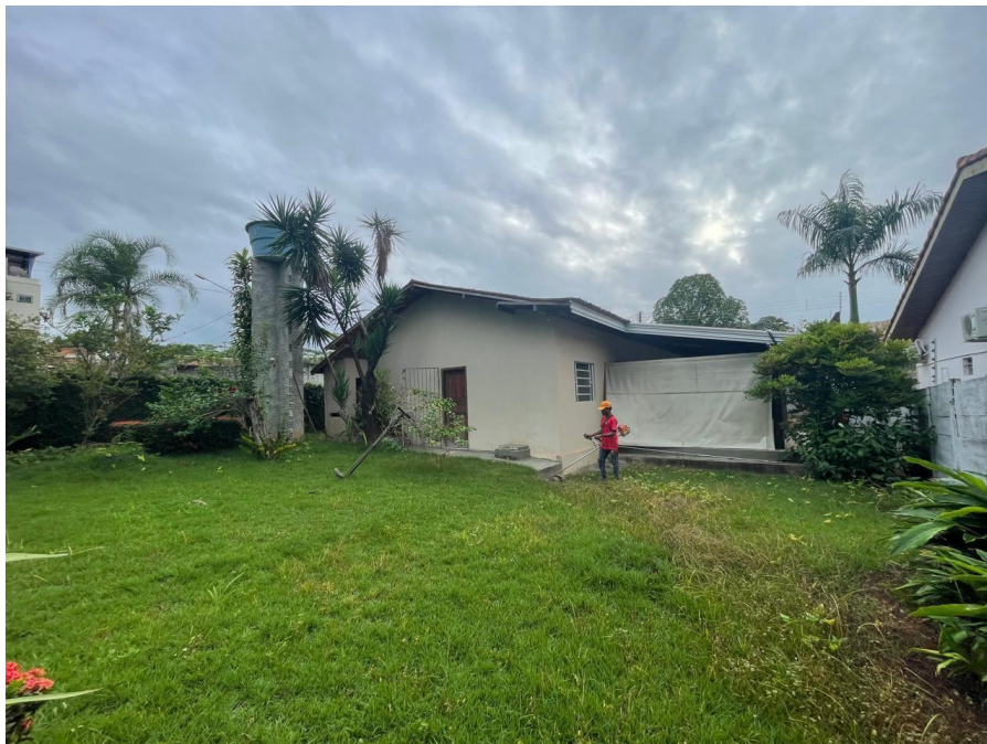
IMAGEM 5: VISTA POSTERIOR DA EDIFICAÇÃO
