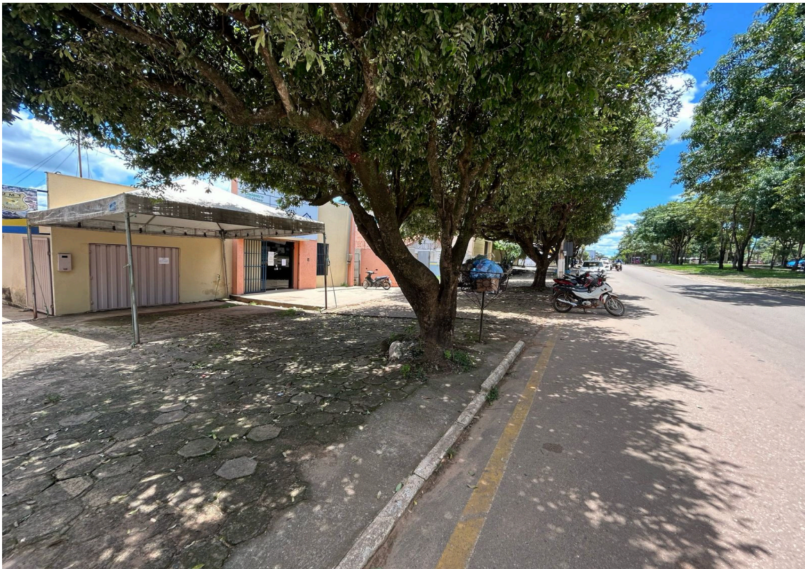
IMAGEM 1: VISTA LATERAL DIREITA À EDIFICAÇÃO
