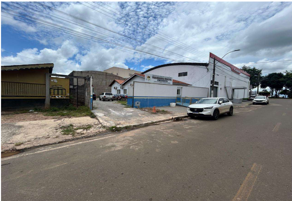
IMAGEM 1: VISTA LATERAL DIREITA À EDIFICAÇÃO
