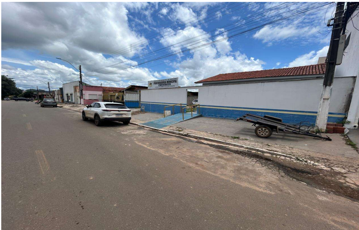
IMAGEM 2: VISTA LATERAL ESQUERDA À EDIFICAÇÃO
