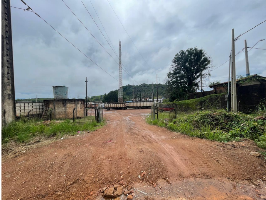
IMAGEM 2: VISTA LATERAL ESQUERDA À EDIFICAÇÃO
