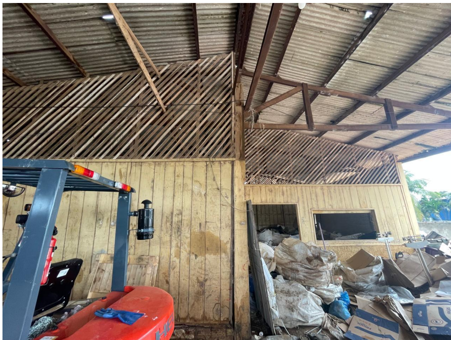
IMAGEM 7: VISTA INTERNA DO GALPÃO
