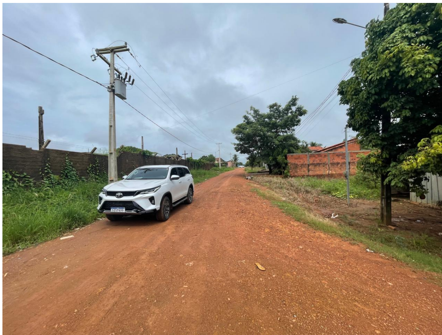
IMAGEM 1: VISTA LATERAL DIREITA À EDIFICAÇÃO
