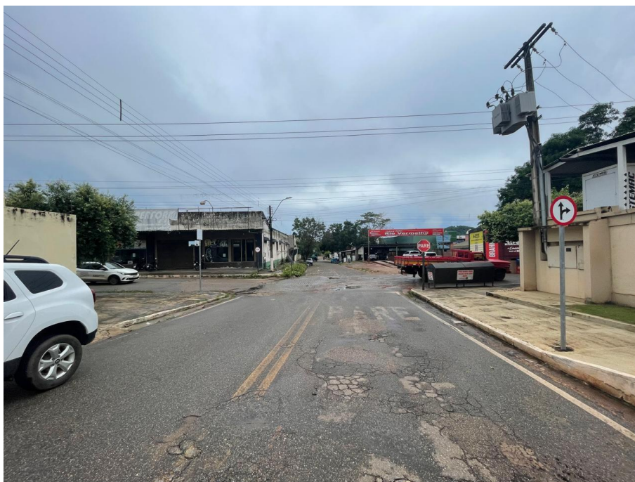
IMAGEM 1: VISTA LATERAL DIREITA À EDIFICAÇÃO
