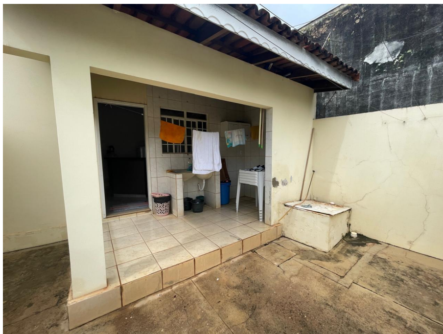
IMAGEM 5: VISTA POSTERIOR DA EDIFICAÇÃO
