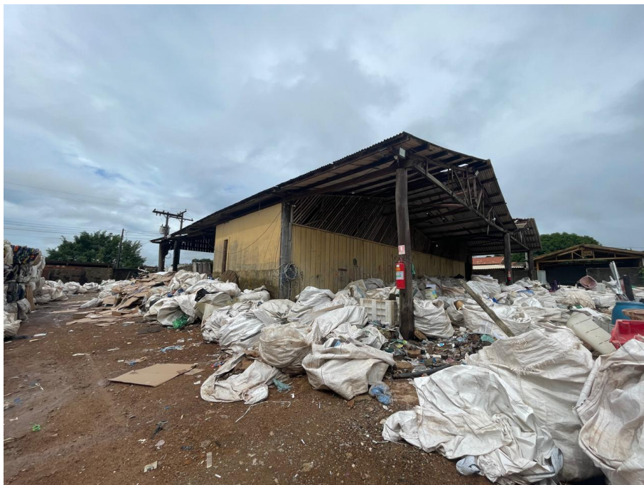
IMAGEM 5: VISTA GALPÃO TODO EM MADEIRA
