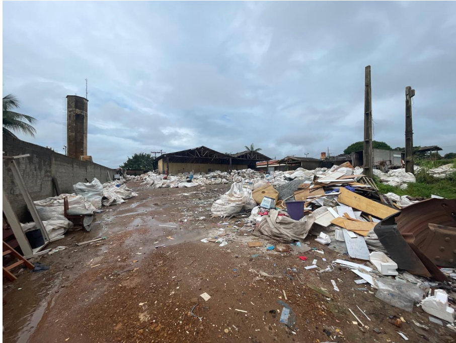
IMAGEM 4: VISTA ANTERIOR DA EDIFICAÇÃO
