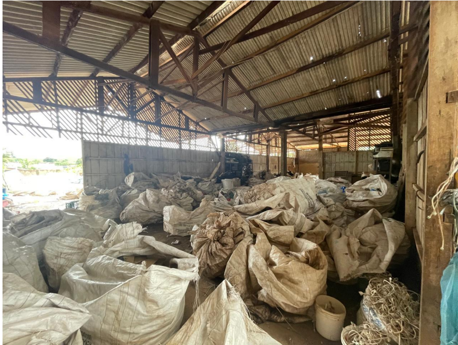
IMAGEM 6: VISTA INTERNA DO GALPÃO
