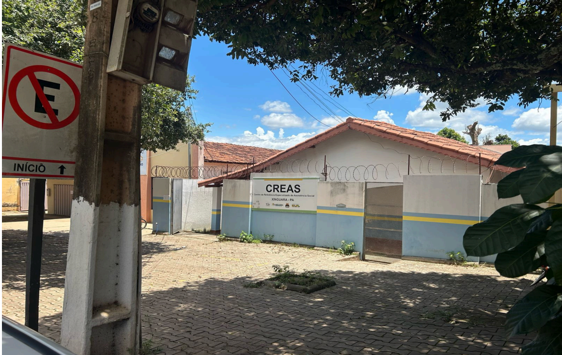
IMAGEM 2: VISTA LATERAL ESQUERDA À EDIFICAÇÃO
