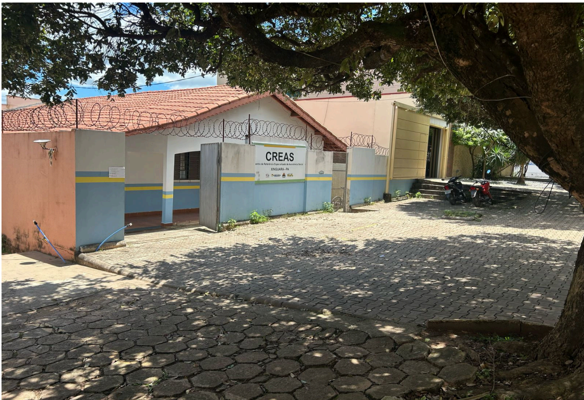
IMAGEM 1: VISTA LATERAL DIREITA À EDIFICAÇÃO
