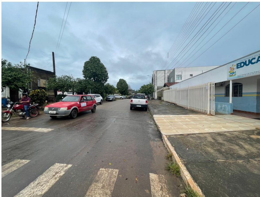
IMAGEM 2: VISTA LATERAL ESQUERDA À EDIFICAÇÃO
