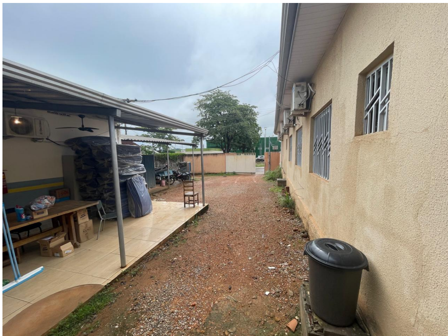
IMAGEM 5: VISTA POSTERIOR DA EDIFICAÇÃO
