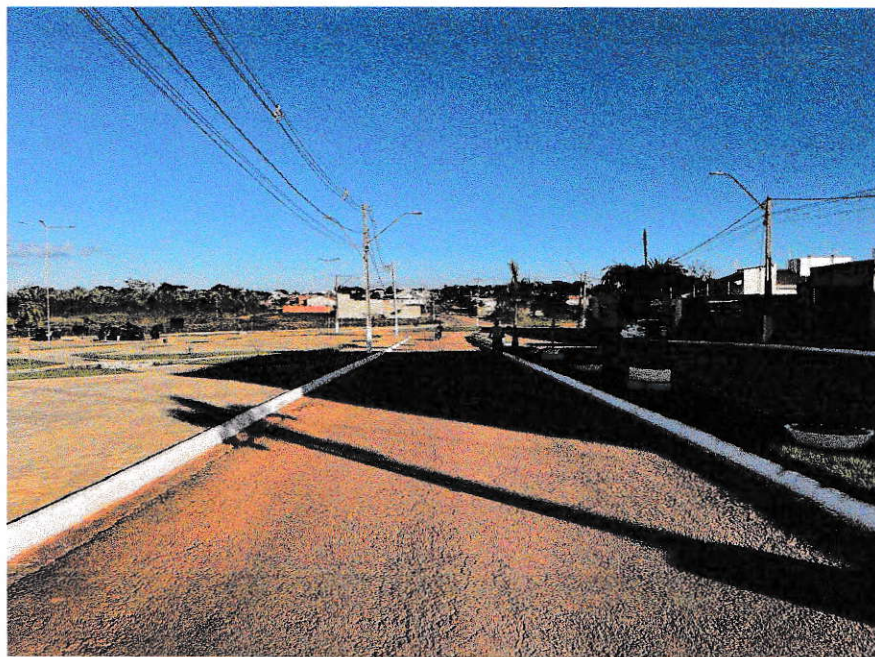
IMAGEM 1: VISTA LATERAL DIREITA À EDIFICAÇÃO
