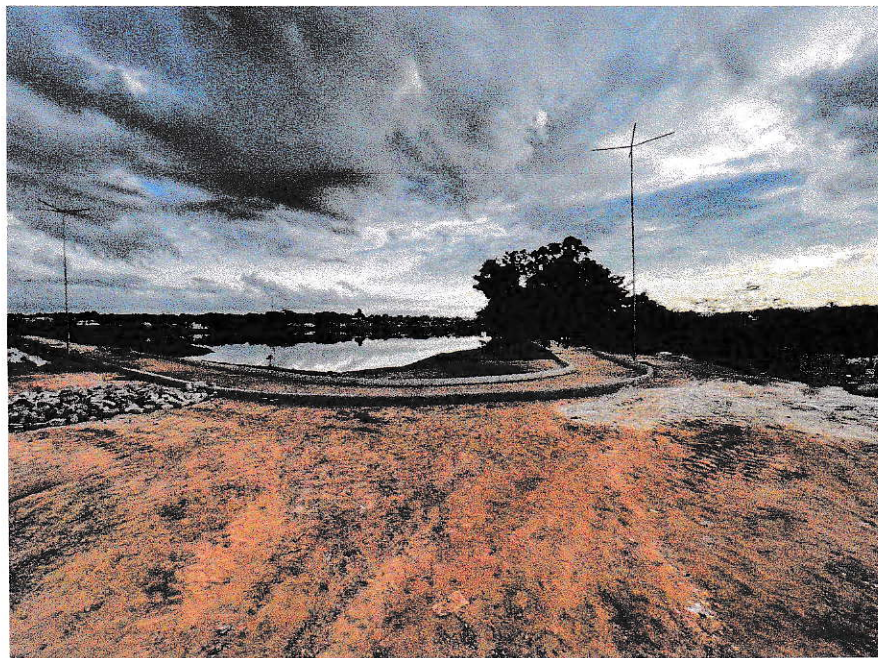
IMAGEM 2: VISTA LATERAL ESQUERDA À EDIFICAÇÃO
