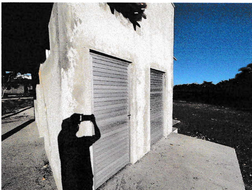
IMAGEM 5: VISTA LATERAL ESQUERDA – ACESSO AOS SANITÁRIOS
