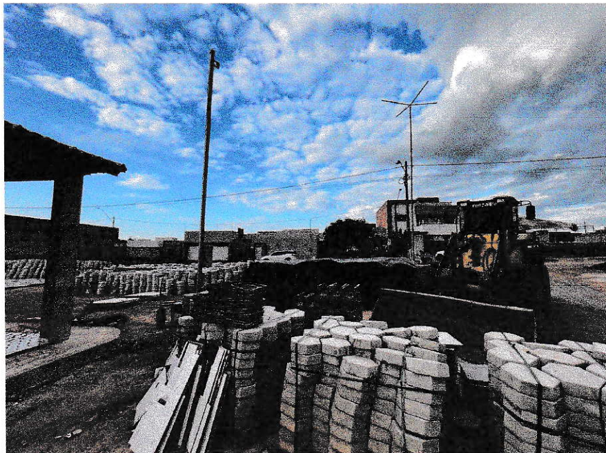
IMAGEM 1: VISTA LATERAL DIREITA À EDIFICAÇÃO
