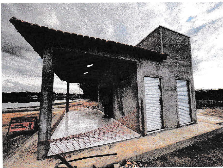
IMAGEM 5: VISTA LATERAL ESQUERDA – ACESSO AOS SANITÁRIOS
