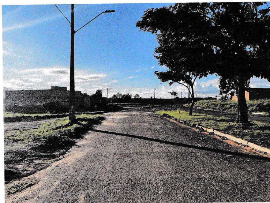
IMAGEM 1: VISTA LATERAL DIREITA À EDIFICAÇÃO
