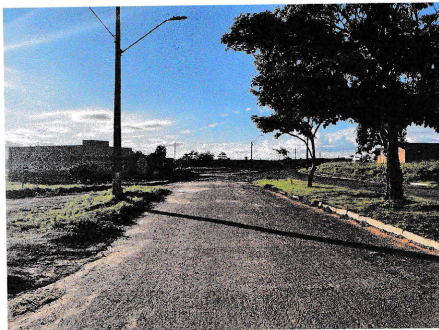
IMAGEM 1: VISTA LATERAL DIREITA À EDIFICAÇÃO
