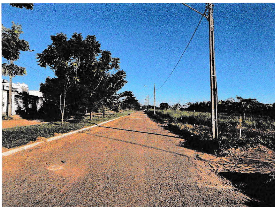
IMAGEM 2: VISTA LATERAL ESQUERDA À EDIFICAÇÃO
