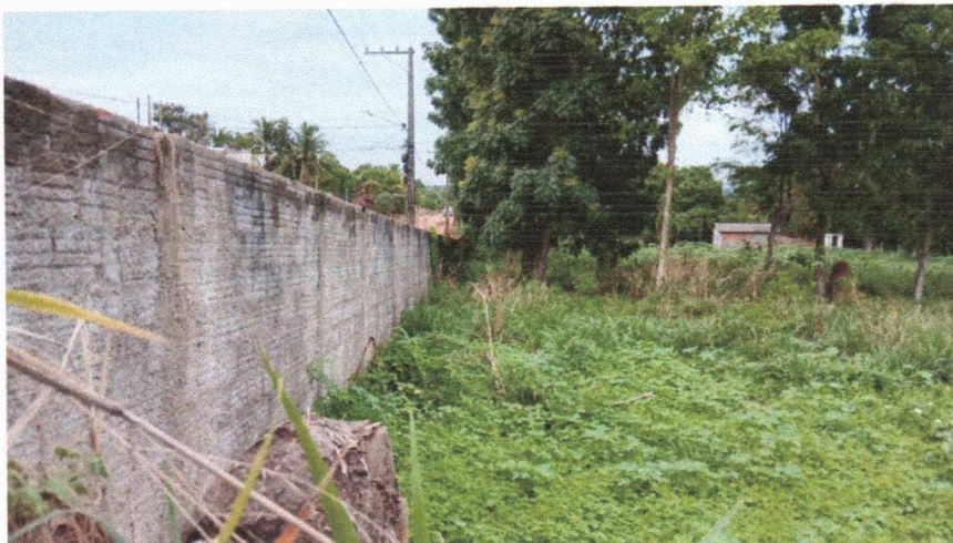
VISTA DO MURO NA PARTE DA FRENTE
